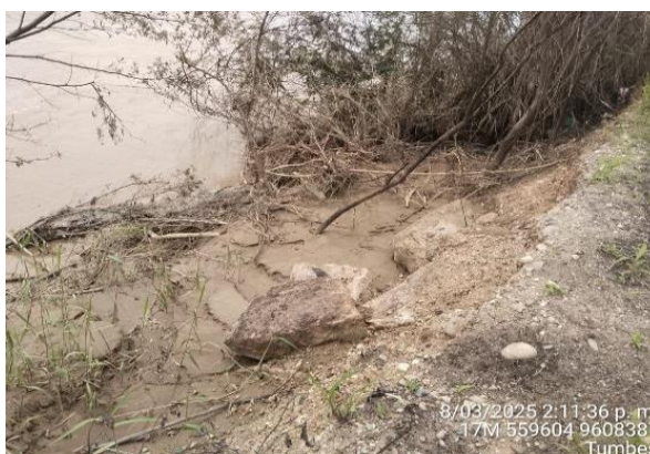
FIGURA N°02: ANTIGUO ENROCADO FUE EROSIONADO.
