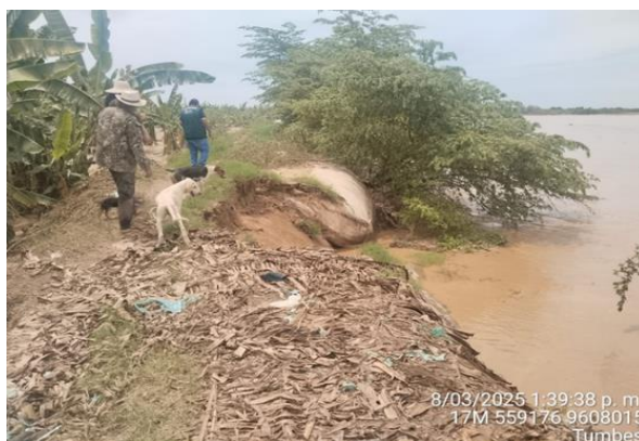
FIGURA N°03: GEOBOLSAS QUE FUNCIONABAN COMO DEFENSA RIBEREÑA FUERON ARRASTRADAS POR EL RÍO.
